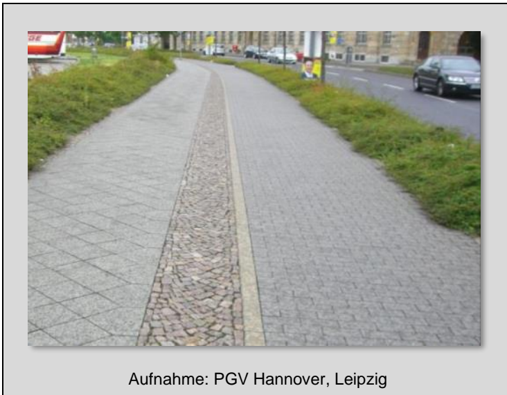
Abbildung 1-7: Vom Gehweg taktil wahrnehmbar, baulich getrennter Radweg
