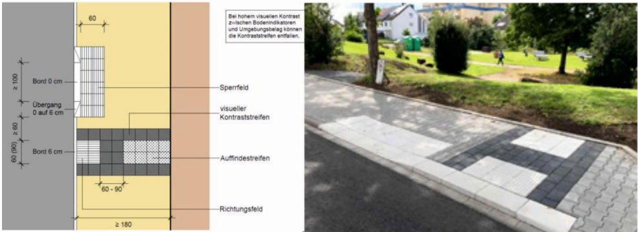
Ungesicherte Überquerungsstelle mit differenzierter Bordhöhe
