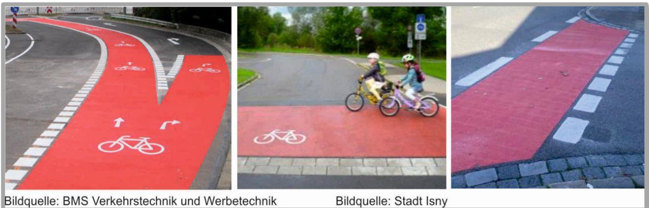
Abbildung 8-9: Beispiele eingefärbte Radfurten an Knoten / Einmündungen
