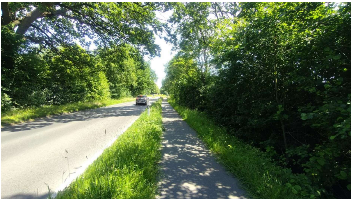
Jersbeker Straße mit begleitenden Knicks mit Hasel, Eichenüberhälter, Hopfen, betroffen durch die Herstellung der Zufahrt zum Gelände
